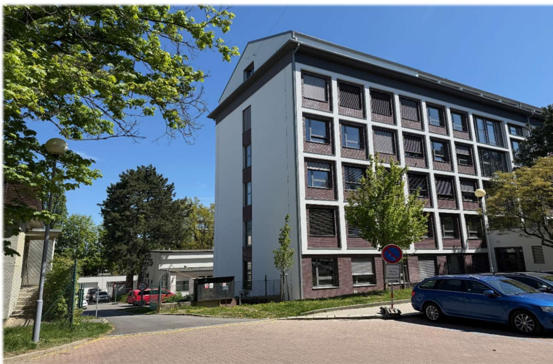
Vnější plášť budovy po rekonstrukci
