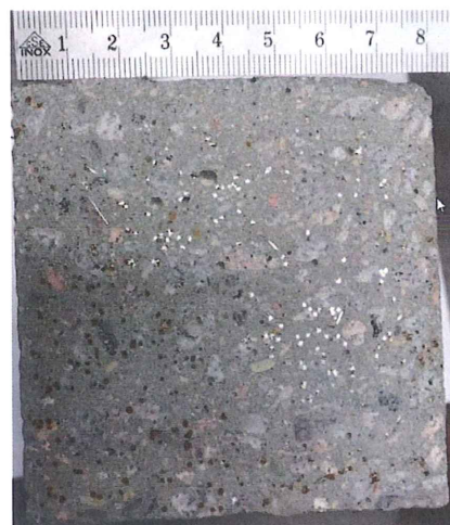
Obr. 4. Struktura studovaného betonu kamenivo do 8 mm směr sedání
